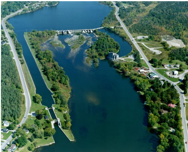
Écluse 13 de Campbellford et barrage
