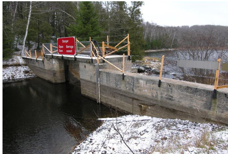
Le barrage du lac Loon avant les travaux
