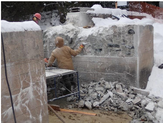
Enlèvement du béton endommagé
