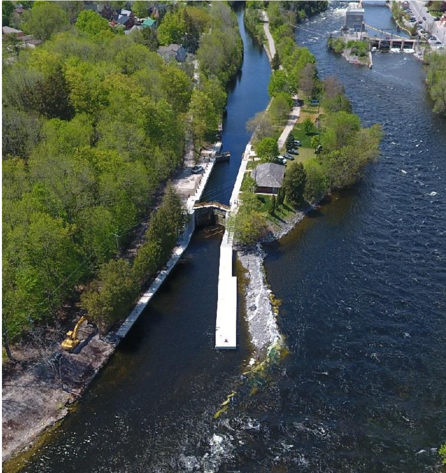
Réparation du béton de l'écluse 26 de Lakefield
