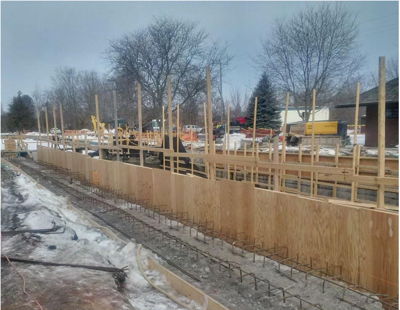
Installation des barres d'armature à l'écluse 26 de Lakefield
