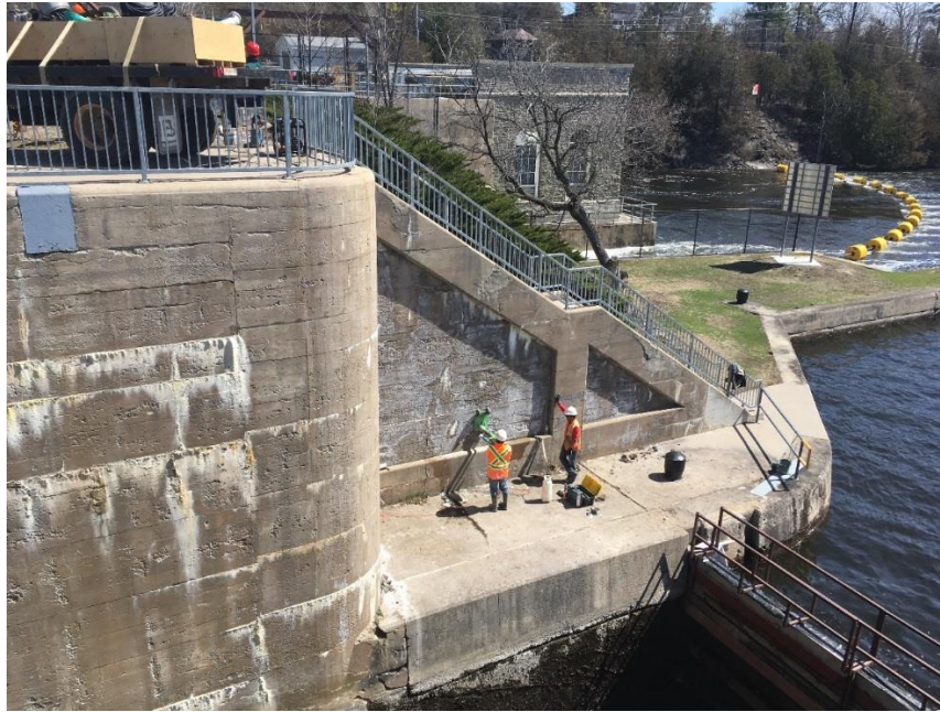
Des travailleurs effectuent des travaux de carottage dans le mur de béton d'une écluse
